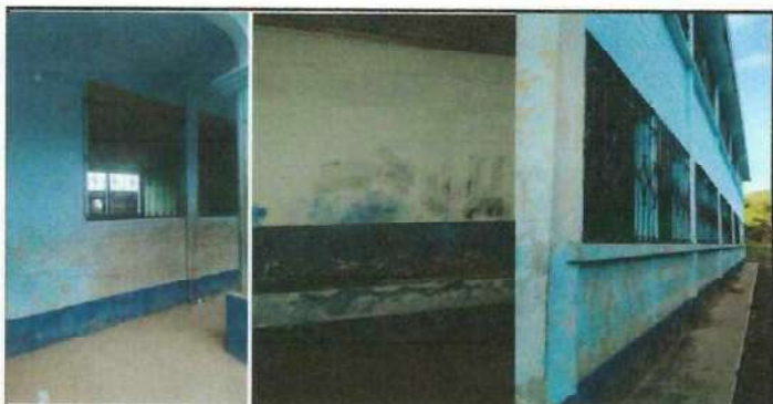
Foto 5: Se observa deterioro de pintura: En todas las paredes de adentro y fuera necesita renovación de pintura.
