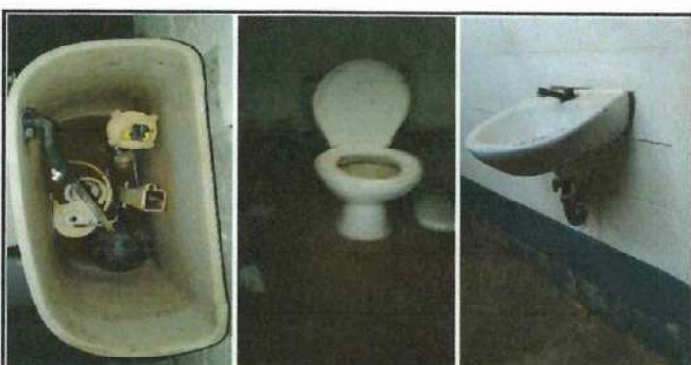
Foto 6: Se observa deterioro de baños: Necesita cambio de tazas y accesorios.
