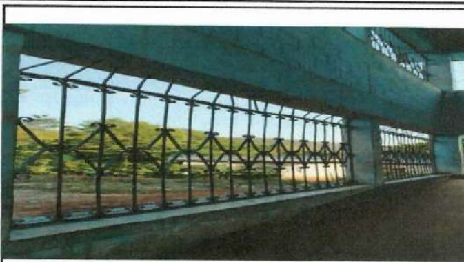
Foto 2: Se observa deterioro de piso: Sustitución torta de cemento del corredor del modulo.
